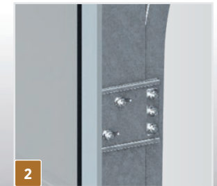
Spåren fästs vid öppningsramen med skruvar
